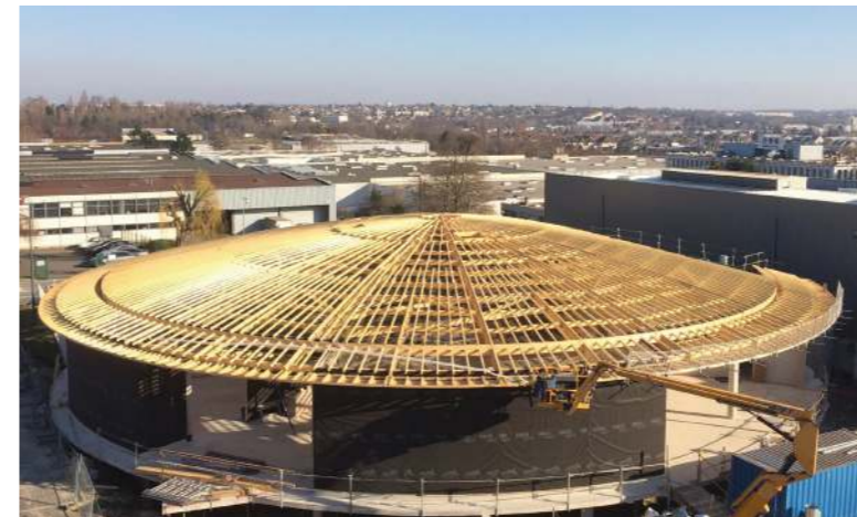
Intersport France à Longjumeau (91) par Cruard Charpente Construction Bois - Charpente en épicéa massif et Lamellé collé français Monnet Sève Sougy
