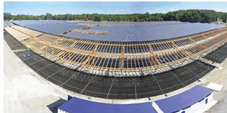
Ferme piscicole de Mézos (40) - Structure en douglas français lamellé collé Monnet Sève Sougy
